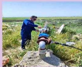
نصب کنتور مغناطیسی حجمی در محل ایستگاه پمپاژ روستای برزل آباد شهرستان شیروان
