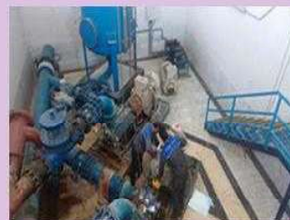
تعویض پمپ آب ایستگاه پمپاژ کرنخ شهرستان گرمه
