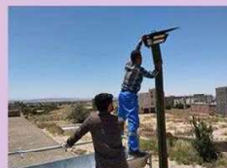
تعویض پروژکتورهای ایستگاه پمپاژ سیدجمال شهرستان اسفراین
